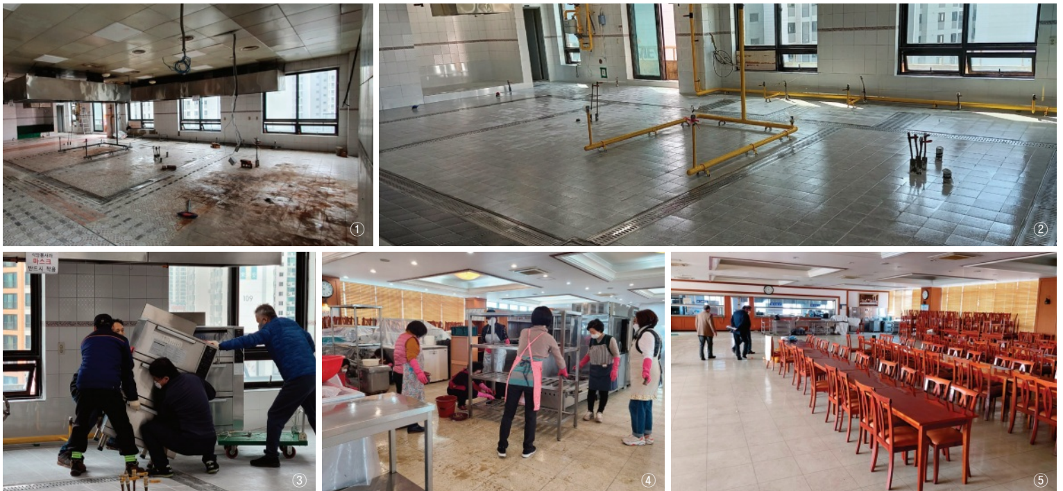
① 공사전 8층 주방 ② 공사 후 8층 주방 전경 ③, ④ 공사 중 도움을 주신 스테반회, 권사회, 직원들 ⑤ 정리된 8층 만나홀
