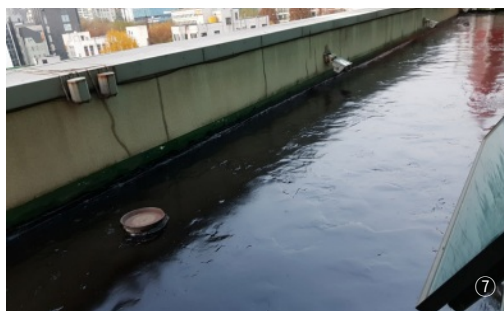
①-③ 9층 쓰레기 정리 ④ 대형장비를 이용한 9층 쓰레기 제거 ⑤-⑦ 5층 베란다 방수도장 공사 현장 ⑧-⑭ 8층 식당 공사 시작 현장
